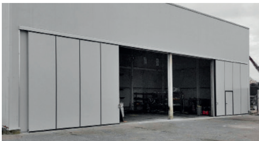
Külső nézet, kétszárnyú tolókapu személybejáróval alacsony küszöbvel
